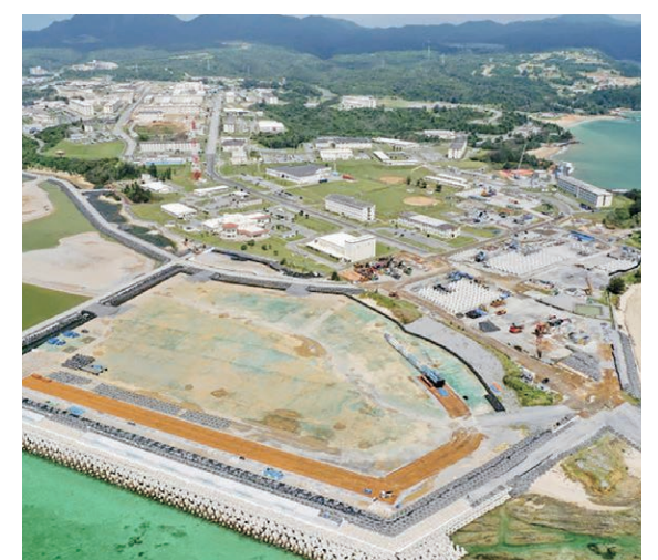
沖縄・辺野古の米軍新基地建設現場
