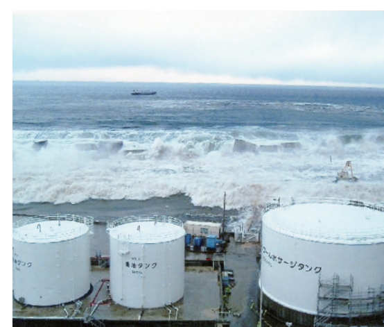
福島第一原子力発電所 津波被災状況 (提供:東京電力ホールディングス)
