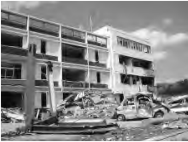
水没した陸前高田市役所
