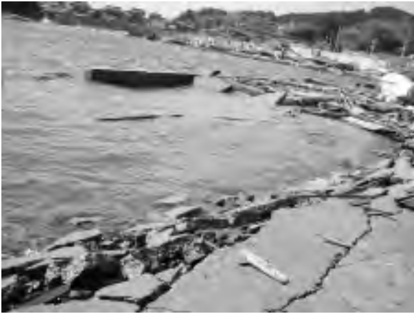
陸前高田市内の崩壊した漁港
