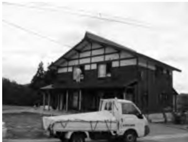
山古志での公営住宅建設（2007年10月撮影）
