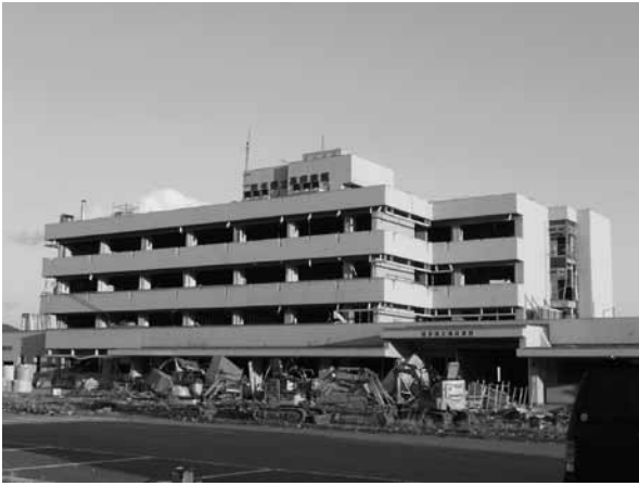
津波被害を受けた県立高田病院
