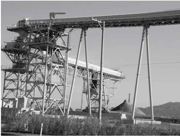
かさ上げ用の土砂を運搬する陸前高田市の巨大ベルトコンベアー（2014年11月22日）
