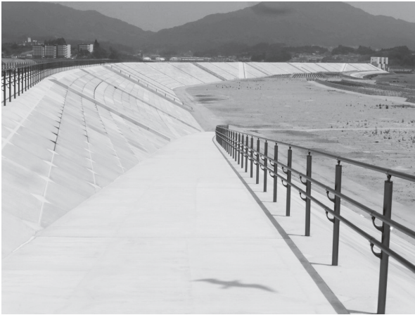
完成した陸前高田市の海岸防潮堤（2017年7月11日）
