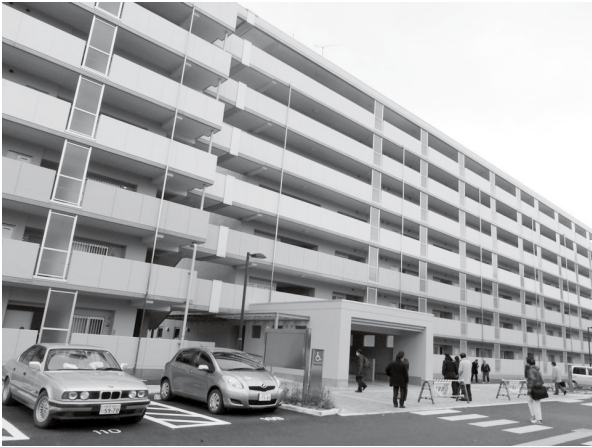
釜石市平田の災害公営住宅（2014年12月）
