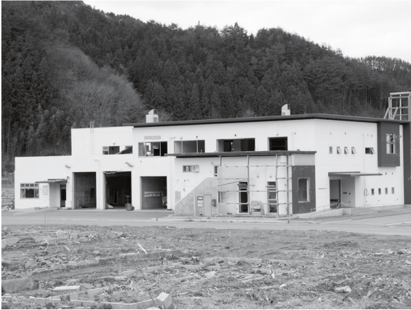
住民200人以上が犠牲になった釜石市鶴住居地区防災センター (2012年4月20日)
