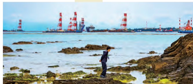
「杭打ちの工事が進む辺野古新基地予定地」～全労連青年部「ユニオンアカデミーベースツアーin沖縄(2/22～24)より
